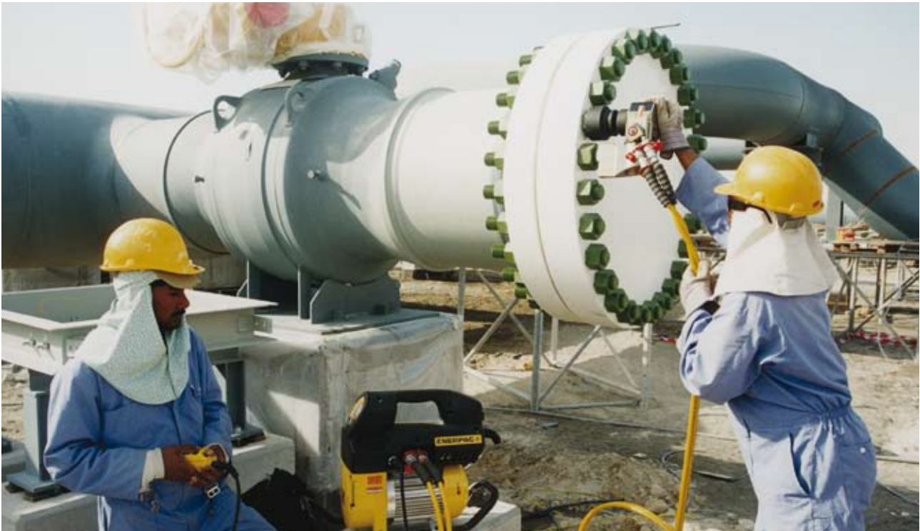
Utilizzando una chiave dinamometrica idraulica si può tensionare in modo controllato la giunzione a bullone/dado, applicando al bullone il precarico giusto, in osservanza delle prescrizioni del costruttore.
